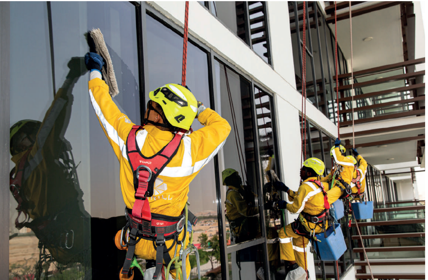
Façade cleaning rope access operations. Operaciones de limpieza con cuerdas en fachadas. Dubai, UAE (courtesy of Emrill Services, ph. Teddy Arago).
